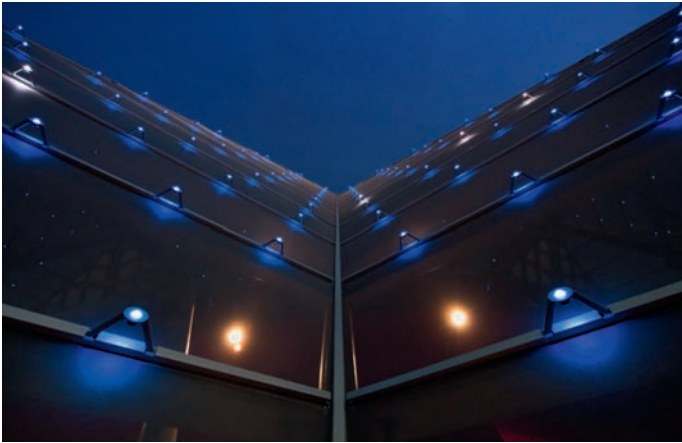
▲ Leuchtenanordnung und Verkabelung an der semitransparenten Membranfassade
