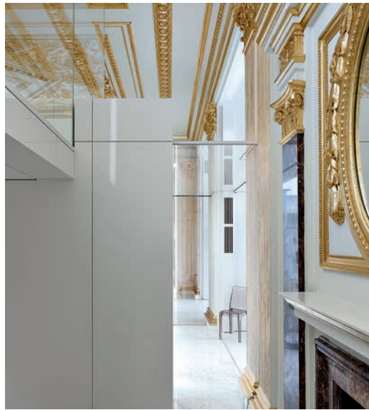
Wo sich Alt und Neu begegnen, bilden mittels Laserschnitt passgenau angeschlossene Glasfugen den Übergang. • Where the old and the new meet, exactly adjoining, laser-cut glass joints indicate the transition.
