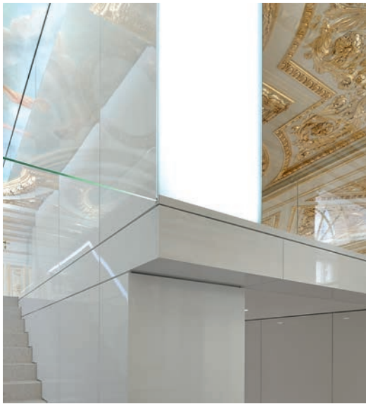
Wo sich Alt und Neu begegnen, bilden mittels Laserschnitt passgenau angeschlossene Glasfugen den Übergang. • Where the old and the new meet, exactly adjoining, laser-cut glass joints indicate the transition.
